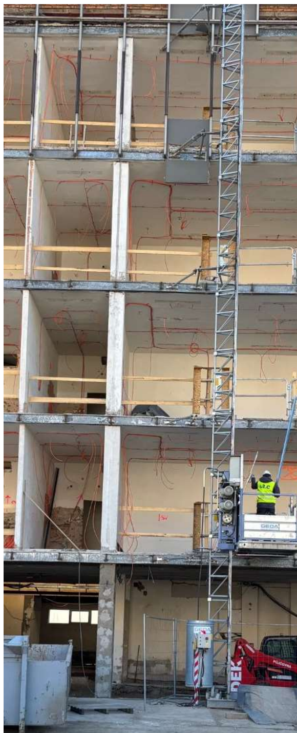
Středisko Stříbrníky v rekonstrukci
